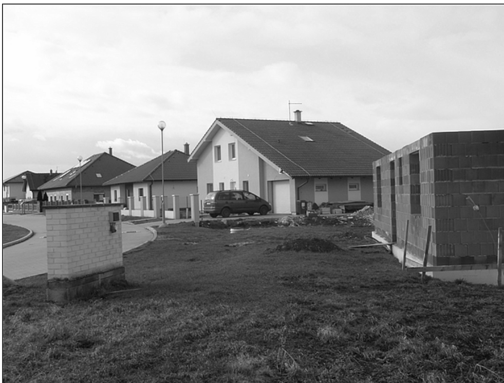
F15 - nová výstavba
