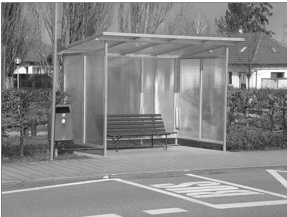
F10 – čekárna autobusové zastávky
