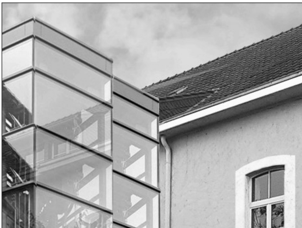
Bezbariérové úpravy - výtah
