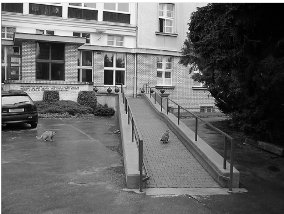
30.2 Bezbariérové úpravy - rampa
