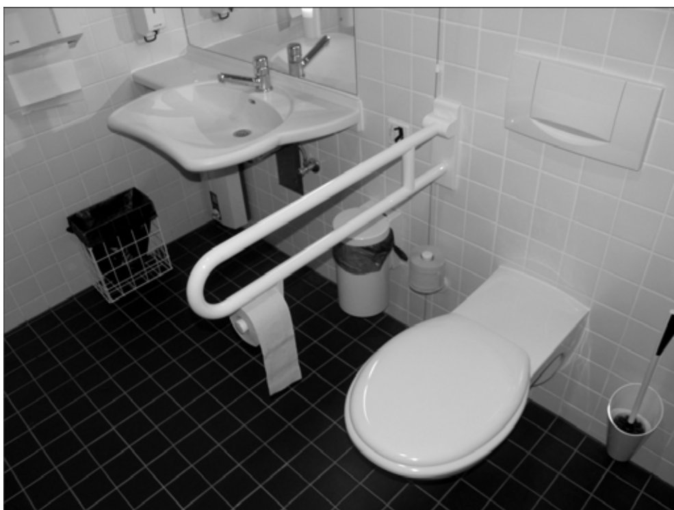
Bezbariérové úpravy - toalety
